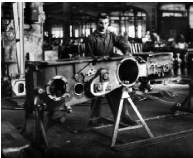
Montage des bâtis
